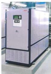
Ce fut l'occasion de présenter les projets en lien avec le développement durable : fonctionnement d'une centrale de cogénération. Celle-ci fonctionne au plus près de l'utilisateur de chaleur pour valoriser l'ensemble de la production d'énergie en limitant les pertes.
