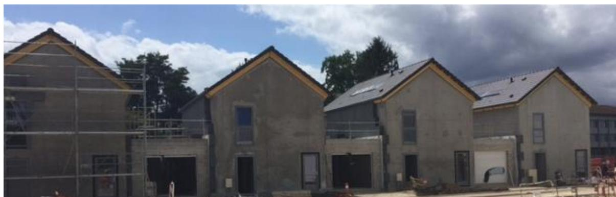
Sur le toit sont intégrés 2 capteurs héliothermiques afin de produire l'eau chaude sanitaire. Ce procédé de pompe à chaleur (COP maxi 7) permet d'assurer l'eau chaude sanitaire des logements. L'énergie extérieure peut être absorbée jusqu'à une température extérieure de -20°C.
