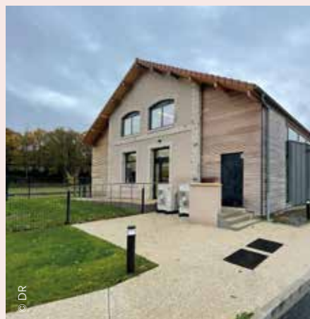
Réhabilitation de l'ancienne gare d'Esternay.
