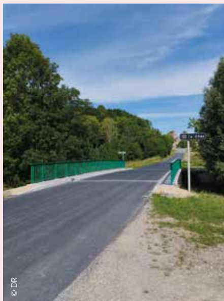
Réparation du pont franchissant La Chée à Vroil.
