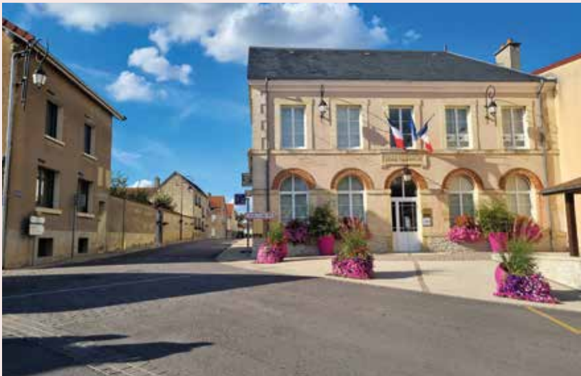
Réfection de la voirie, commune de Jouy-lès-Reims.
