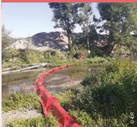
Un des dispositifs temporaires mis en place dans le cadre des travaux de reconstruction du pont de la Chée à Merlaut pour éviter une pollution de la rivière.
