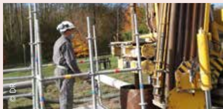
Création d'un nouveau forage eau potable et mise aux normes de la station de pompage à l'aéroport Vatry et ses ZAC.
