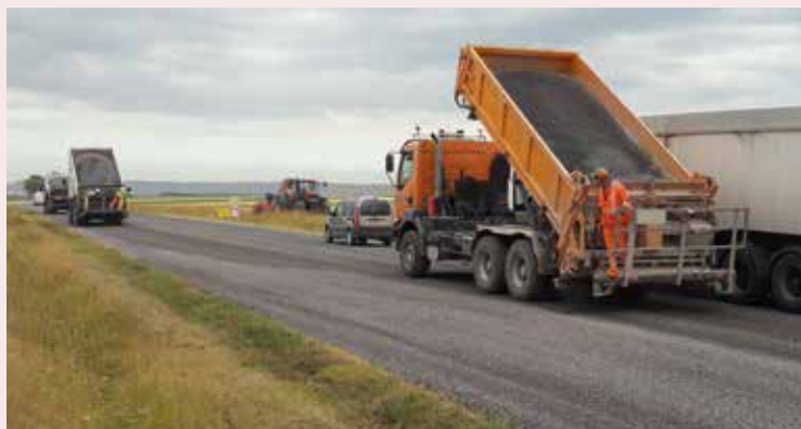
L'étape de gravillonnage qui permet d'apporter de l'adhérence à la chaussée.
