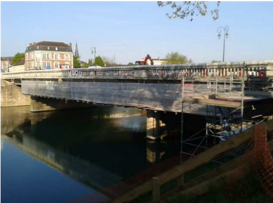
Chantier: OA de d'Épernay
